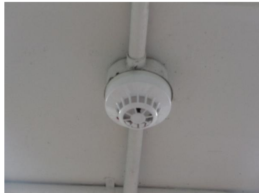
รูปที่ 3-40 Smoke Detector
