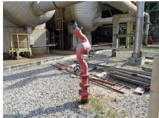
รูปที่ 3-46 Fixed Water Monitor
