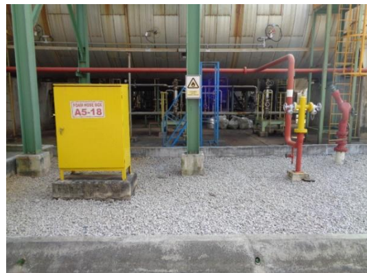
รูปที่ 3-48 Foam Hydrant
