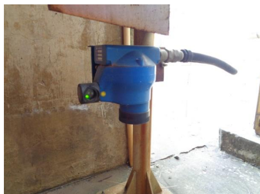
รูปที่ 3-38 Gas Detector
