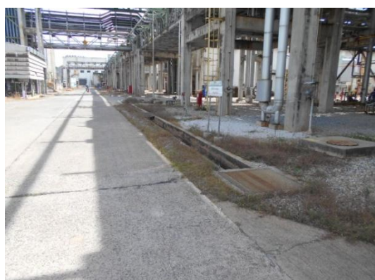
รูปที่ 3-10 รางระบายน้ำแบบเปิด
