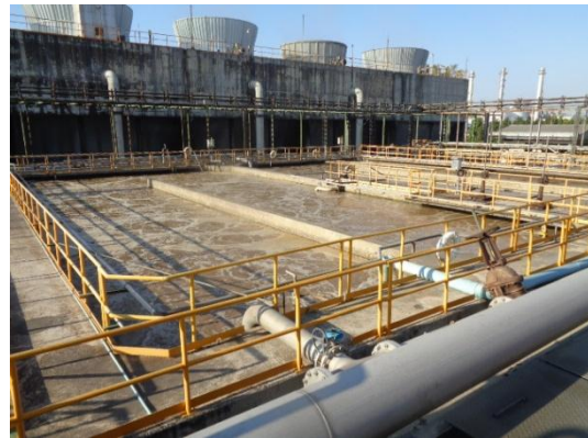
รูปที่ 3-13 Activated Sludge System
