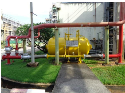
รูปที่ 3-49 Fixed Foam Discharge Outlet
