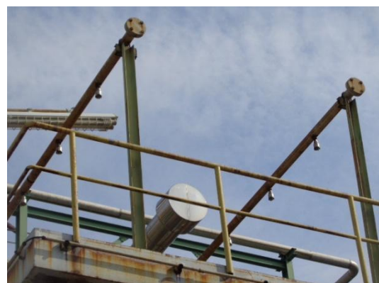
รูปที่ 3-50 Fixed Foam Spray System
