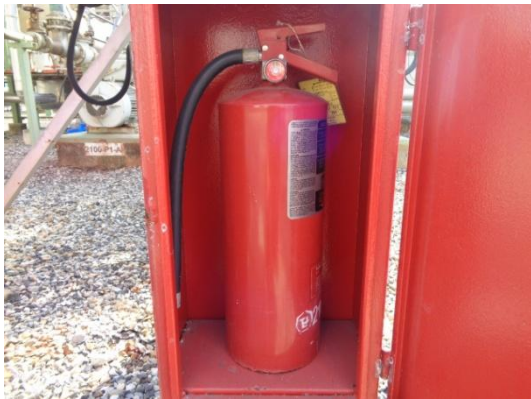
รูปที่ 3-51 Portable Fire Extinguisher
