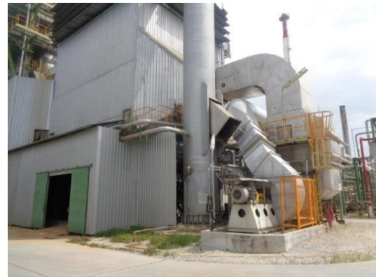
รูปที่ 3-9 อุปกรณ์บำบัดฝุ่น (Electrostatic Precipitator) จาก Boiler Type
