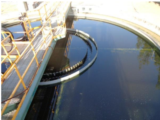
รูปที่ 3-14 Flocculation & Sedimentation
