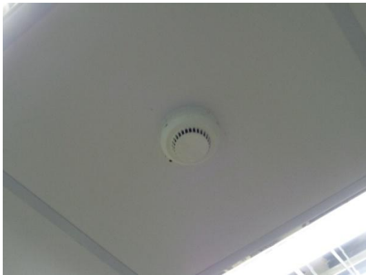
รูปที่ 3-39 Heat Detector
