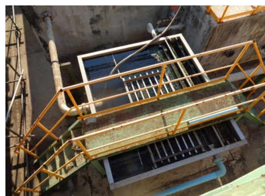
รูปที่ 3-11 Oil Separation System
